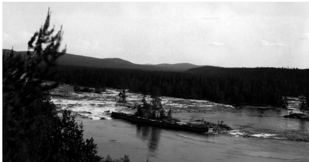
Vy från norra stranden, mot sydväst. Här syns den tidigare trækistan, vid platsen där hängbron idag ansluter. Ovanför återfinns idag betongskärmen (5) och nedan ledarmen av sprängsten (6).
