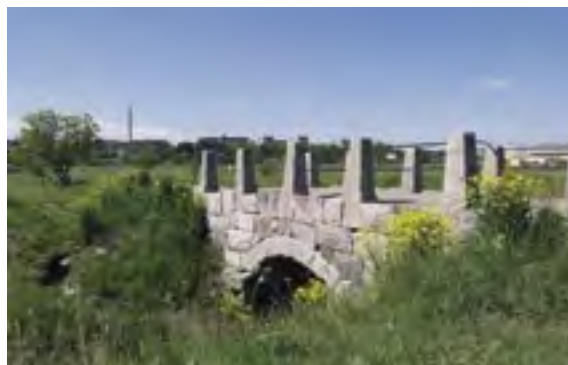
Stenvalvsbron på Göta Landsväg.
